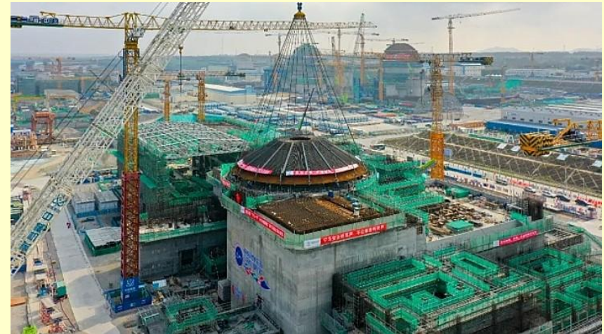
Konstrukce kontejnmentu je dokončena
