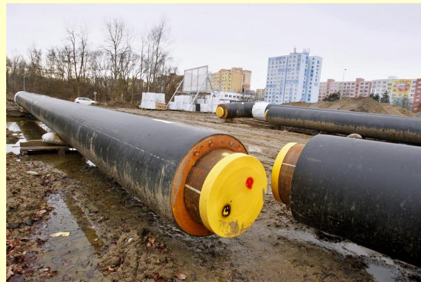
Výstavba horkovodu z Temelína
