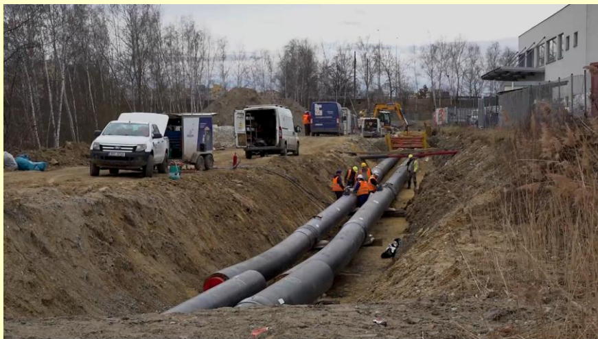
Výstavba horkovodu z Temelínu do Českých Budějovic
