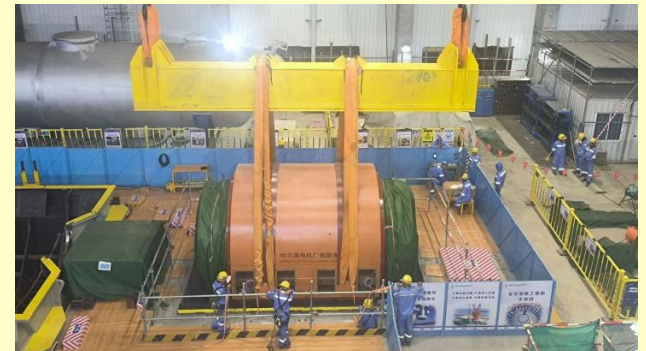
Postup konstrukce, instalace integrované vnitřní části práce na turbíně
